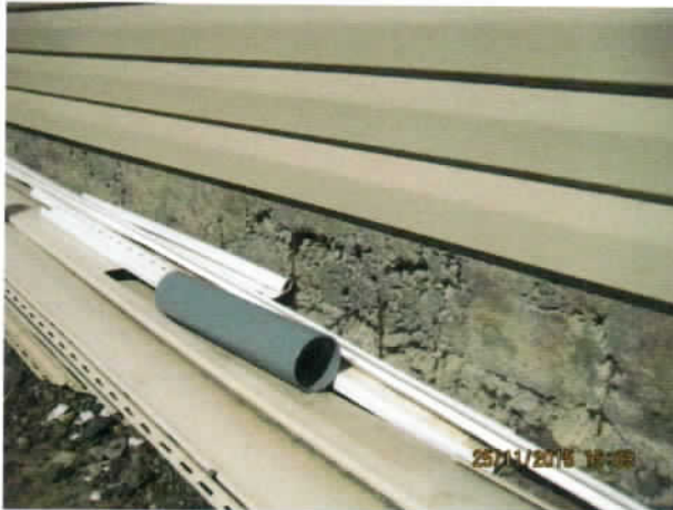
Fotografía N° 1: Segregación de hormigón. Fotografía N° 2: Enfierraduras expuestas.
