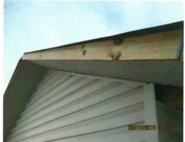
Fotografía N° 10: Tapacán sin revestir.
