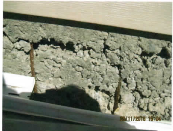
Fotografía N° 1: Segregación de hormigón. Fotografía N° 2: Enfierraduras expuestas.
