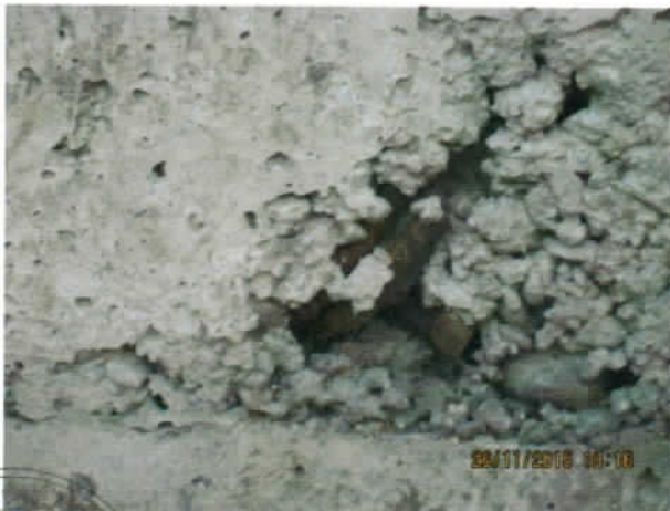
Fotografía N° 3: Enfierraduras expuestas. Fotografía N° 4: Nidos de piedra
