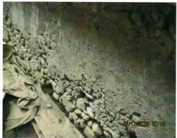
Fotografía N° 3: Enfierraduras expuestas. Fotografía N° 4: Nidos de piedra
